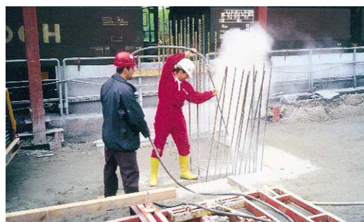
Abb. 9: Bohrlochreinigung mit Druckluftdüsenlanze auf Baustelle
