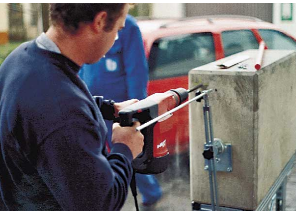
Lehrgang fürs Montieren nachträglich eingemörtelter Bewehrungsstäbe, hier: Hammerbohren mit Bohrhilfe
